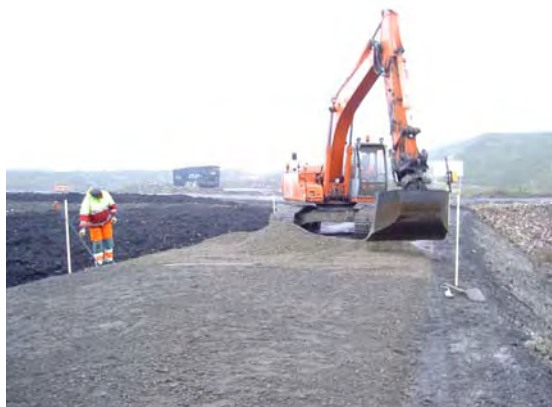
Bild 10. Materialen breddes ut med laserstyrd grävmaskin.
