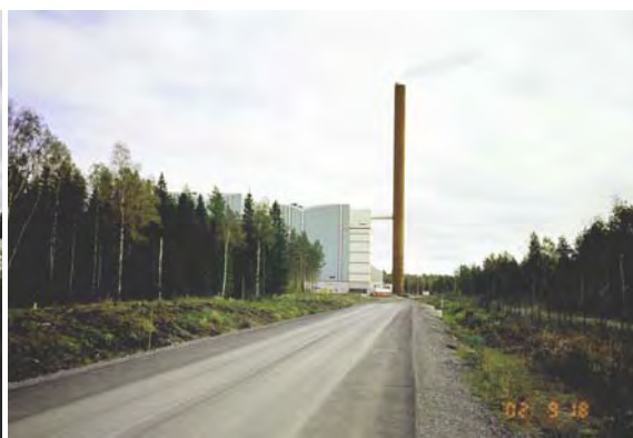
Bild 2. Provväg uppbyggd med slaggrus och med inlagda lysimetrar för uppsamling av lakvatten (ett tidigare försök).
