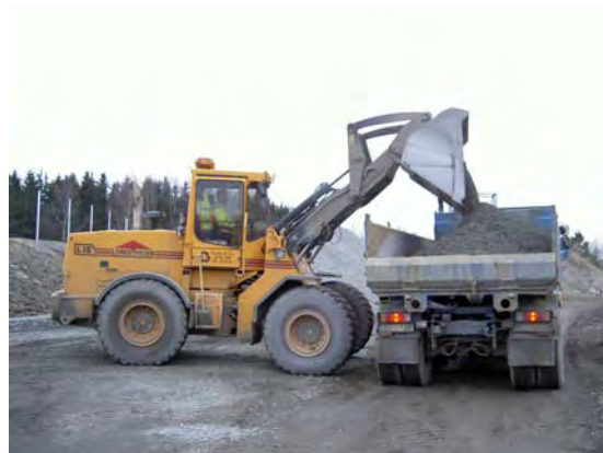
Bild 6. SLAGG-produkterna blandades på plats i Tagene enligt upprättade recept med vägutrustad lastmaskin.
