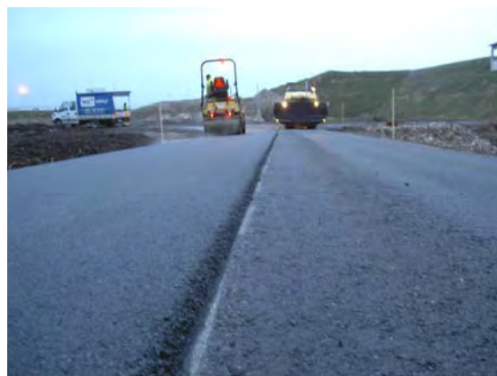
Bild 14. Som slitlager lades 30 mm ABT 11.
