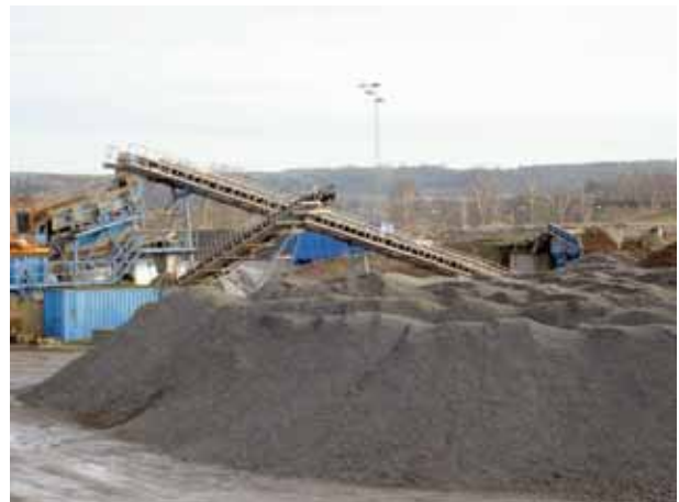
Bild 3. Lagring av färdigt slaggrus med sorteringsanläggning i bakgrunden.
