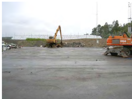
Bild 11. Delar av ytan rensades från metallstycken så att mätningarna kunde genomföras.
