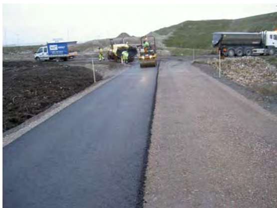
Bild 13. På grusbärlagrets lades först ett lager AG 16.
