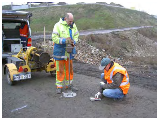
Bild 22. Stabiliteten hos bärlagermaterialen mättes med lätt fallvikt.
