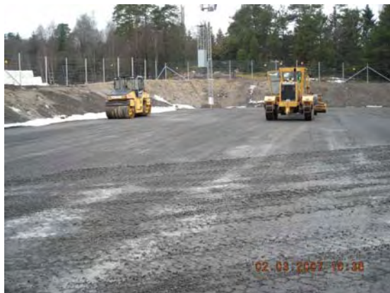
Bild 8. Ytan slutjusterades med ASFALTgrus och vältades innan ytan togs i bruk.
