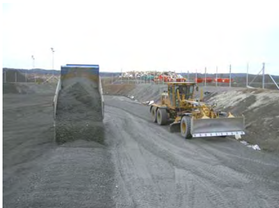
Bild 7. Lastbilen fördelade materialen medan vägghyveln jämnade till.
