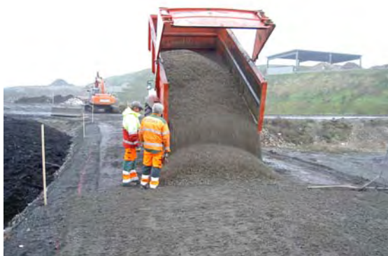
Bild 9. Respektive bärlagermaterial spreds på utstakade avsnitt.
