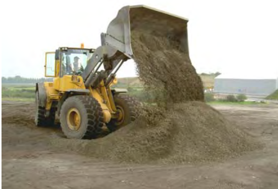
Bild 7. Lastmaskin med våg blandade samman materialen.
