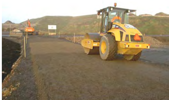
Bild 12. Lagren packades med vibrerande vält.
