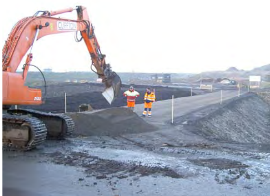
Bild 11. Anslutningarna byggdes med resterande SLAGG-produkter.
