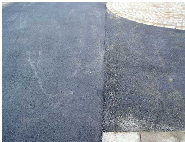
Bild 4-1 Smidig massa (t.v.) jämfört med en grymig massa som förlorat läggbarhet och beständighet.
