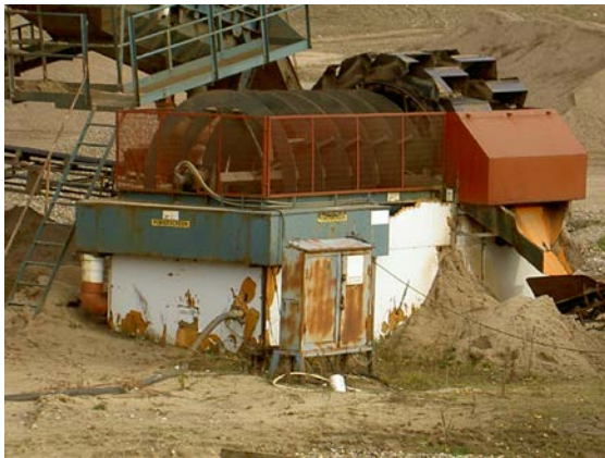
Bild 2-5 Powerscreen de-watering box vaskar fram den rena sanden.
