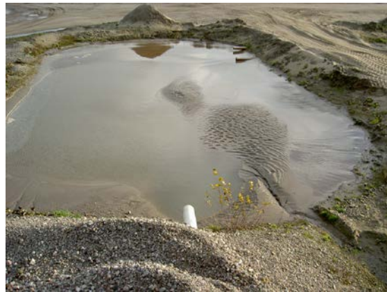
Bild 2-6 Slammet hamnar i en första sedimentationsdam. Vattnet går via utskov genom ytterligare två dammar innan det används på nytt.
