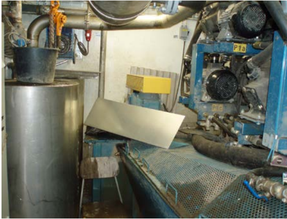
Bild 3-5 Efter 2 mm-sikten hamnar sandslamman i botten av skruvklasseraren. Finslammet pumpas vidare.
