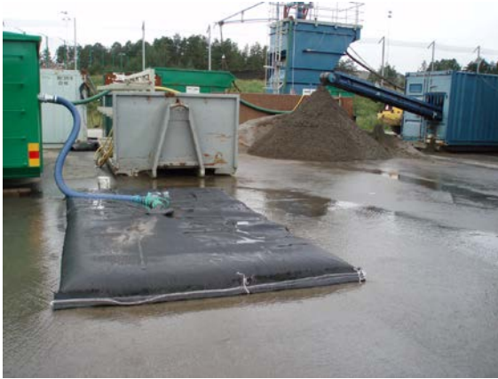
Bild 3-11 Geotube är ett annat sätt att avvattna en slamma. Vattnet sipprar igenom plastväven medan det siltiga finmaterialet stannar kvar.
