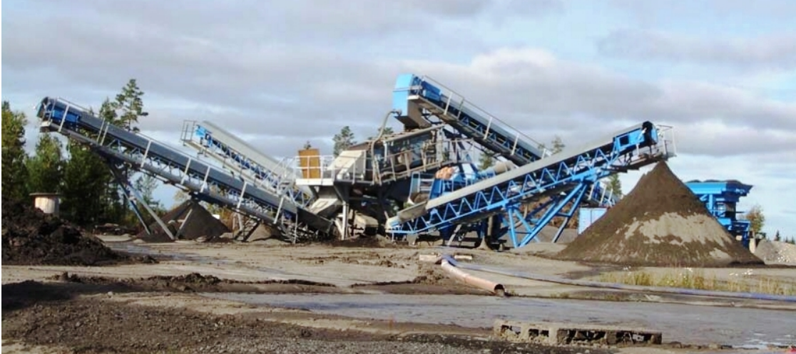
Bild 2-16 NCCs tvättanläggning i Stöningsberget utanför Umeå i färd med tvättning av sopsand. Bild: NCC Roads
