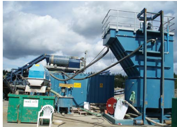
Bild 3-10 I lamellförtjockaren sjunker slammet till botten och pumpas bort till en container. Ytvattnet återförs genom ett överlopp till tvättanläggningen.
