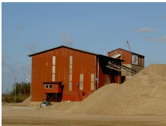
Bild 2-7 Skånska Makadams tvättanläggning i Kvidinge är inrymd i en hög fabriksbyggnad.
