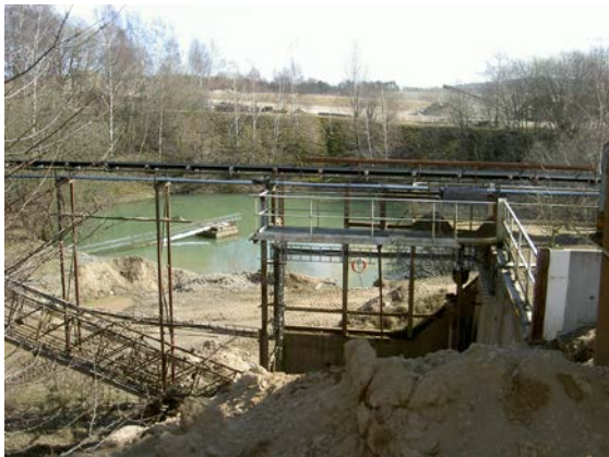
Bild 2-11 Tvättvattnet tas från ett vattenfyllt schakt intill anläggningen.
