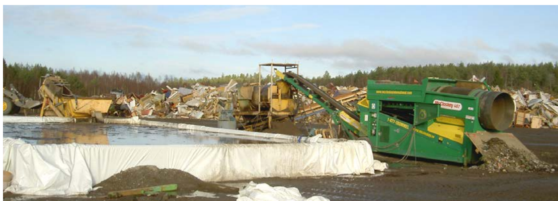
Bild 2-14 SoilTechs tvättsiktanläggning på Djupdalens deponi i Karlstad med sedimentationsdamm. Tvättvattnet återförs från dammens nederdel.
