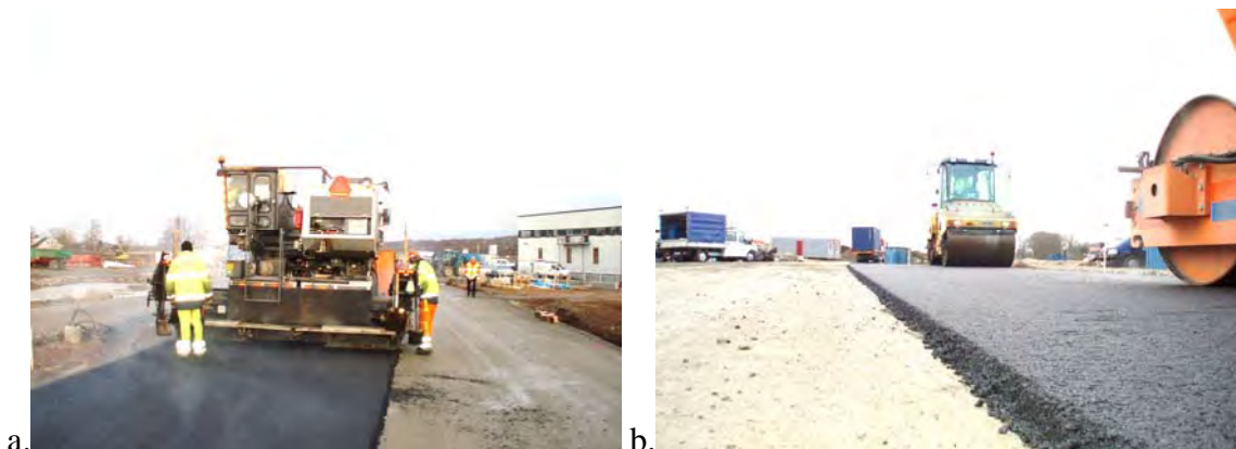
Bild 3-18 Vältarna kunde börja bearbeta FRA-massan direkt efter utläggaren. Kanten på läggardraget bildar en liten slänt som resultat av massans levande karaktär.
