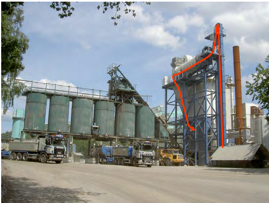
Bild 2-2 Valingeverket med parallelltrumma för separat uppvärmning av returafalt.
