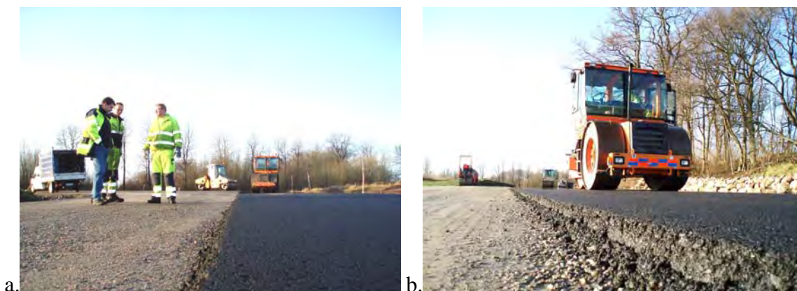
Bild 3-17 Vältförarna väntar tills RA-massan svalnat så att maskinerna kan gå på. Associationerna gick osökt till läggning av kallblandad asfalt. Notera den vertikala kanten, som uppstår med en stum och oflexibel massa.
