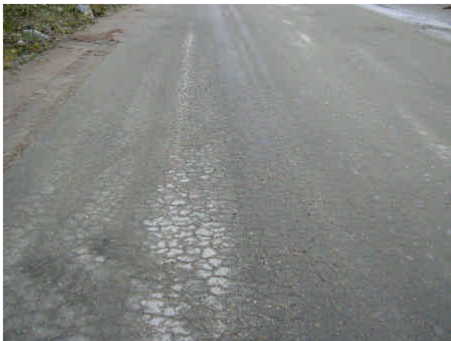
Bild 5.7-1 Utmattningssprickor, eng. ”alligator crackings”, av tung belastning på mjukt underlag.
