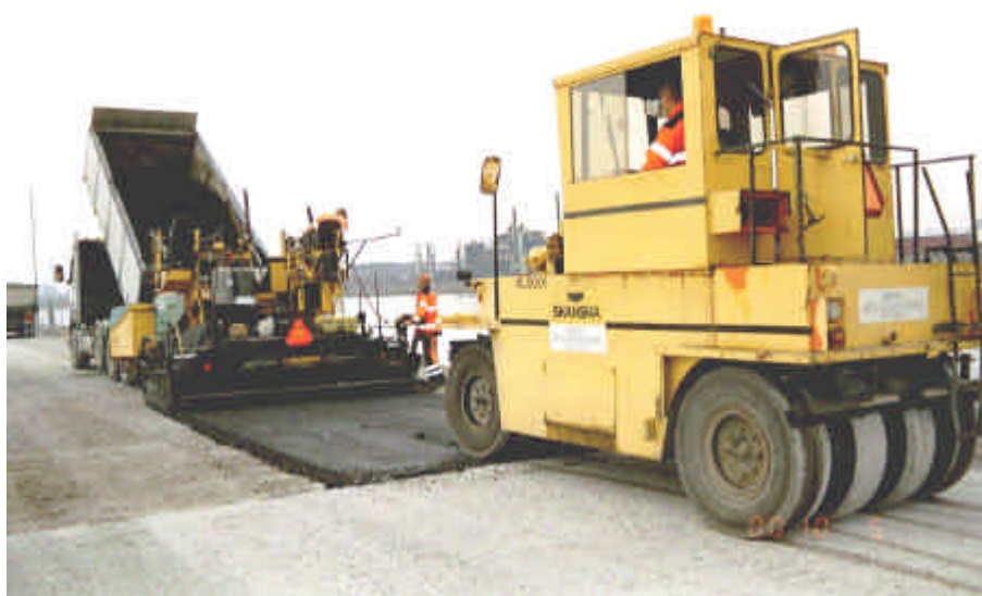
Bild 5.6-3 ... tillsammans med en tung gummihjulsvält.
