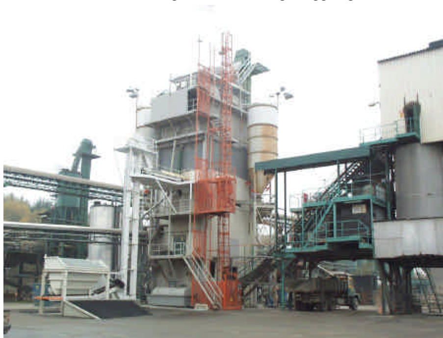
Bild 3.4-1 Skanskas kallblandningsverk med kontinuerlig blandare av typ Lucksta. Verket användes till samtliga undersökta vägbeläggningar.
