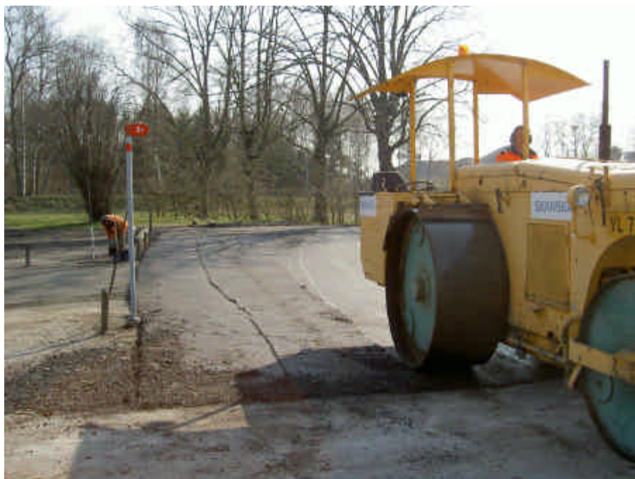
Bild 5.6-2 En tung, statisk vält gör ofta bästa jobbet ...
