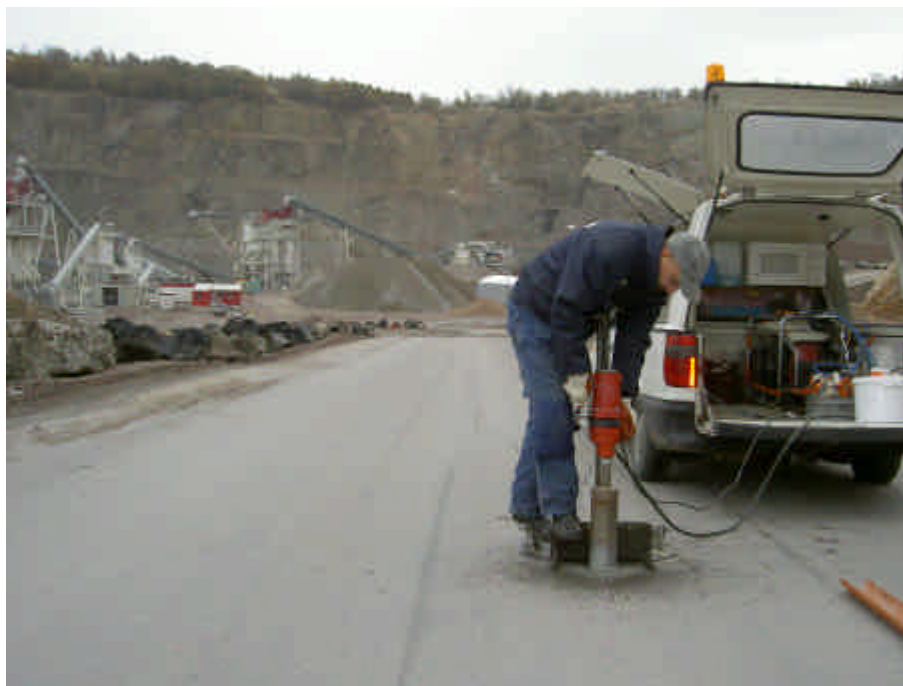
Bild 4.4-1 Borrning för objekt nr 1b (Åstorp, backe) med ROD-bitumen.
