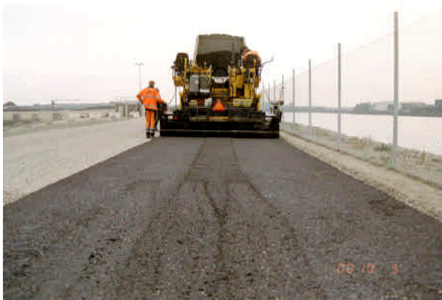
Bild 5.6-1 Läggarcreeden flyter jämnt på den smidiga ROD-massan.
