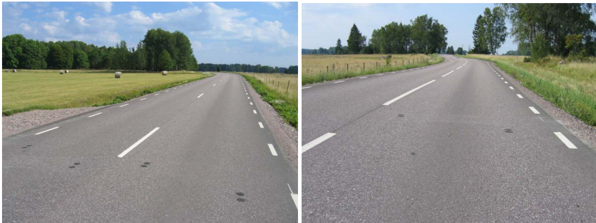
Bild 2-2: Sektion 2/850 med MJOG (vänster vägsida) och MJOG/ROD (höger vägsida) och sektion 3/780 med MJOG/ROD+0,3 (bilden tagen söderut). Foto: Bengt Magnusson, Vägverket
