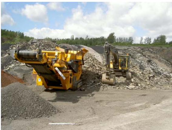
Bild 6-1: Krossning och siktning av returasfalt till ASFALTgrus med mobil utrustning på Skanskas anläggning Dalby.
