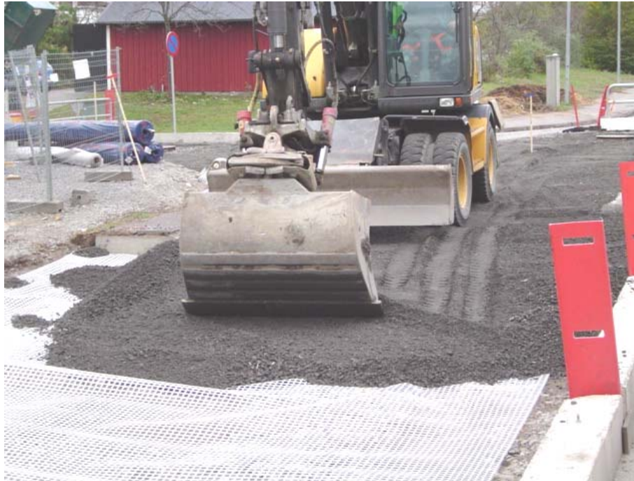
Bild B-3: Utläggning av SAM-produkten ASFALTBär på geonät.
