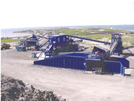
Bild 6-4: SYSAV:s sorteringsanläggning för bottenaska på Spillepeng i Malmö. Foto: SYSAV, Malmö
